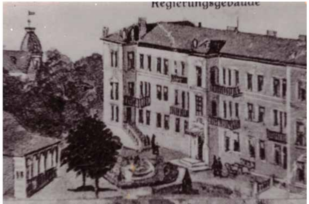
In diesem Gebäude in Sauerbrunn befand sich von 1921 bis 1925 die Landesregierung des Burgenlandes.
