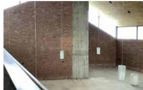
unter den Sitzbänken sowie des Gussasphalts; Abbruch diverser Holzeinbauten um den Altarraum; Abbruch Plexiglasscheiben Windfang; Reinigung Altarmöbel; Sandstrahlen Sichtziegel-Mauerwerk und Sichtbeton im Innenraum; Abbruch nicht mehr funktionstüchtiger Beleuchtungselemente. Durch die bereits erfolgten Arbeiten wurde
